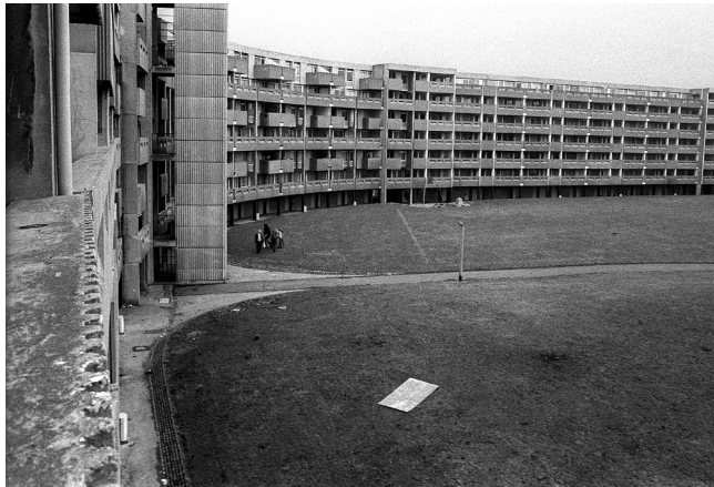
图 6 规划方案与现实的差距。实际的建成效果根本比不上“王室环楼”的品质。 资料来源：艾伦·丹尼（Alan Denney）拍摄，1979
